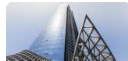
D1 Tower, Dubai
